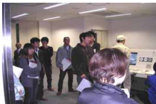
容器包装プラ処理設備の運転制御室
