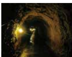
トンネル内部
