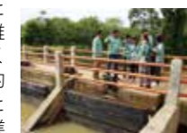
公園職員との水門の開閉検査
