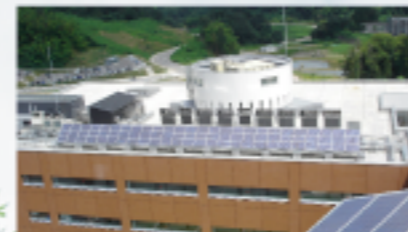
角間キャンパスの自然科学棟に設置された太陽光発電装置。本学では、太陽光発電や風力発電によるクリーンエネルギーも活用しています。
