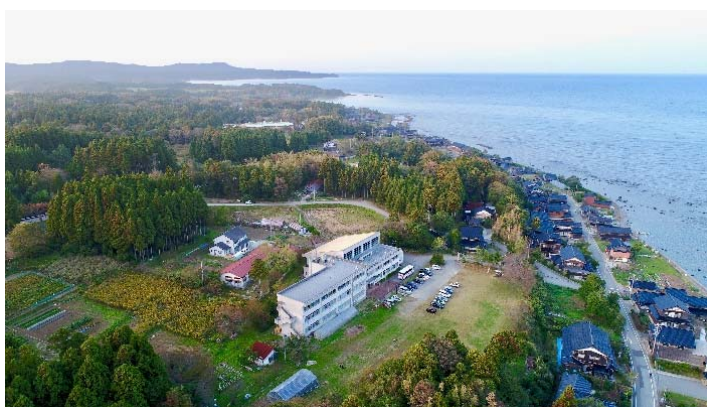
里山里海に囲まれた金沢大学能登学舎（中央の白い建物）
