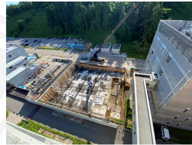
基礎工事 (R6.6)
