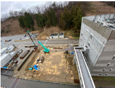
工事着手 (R6.3)
