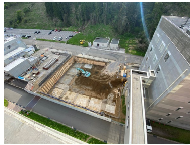
掘削工事 (R6.4)
